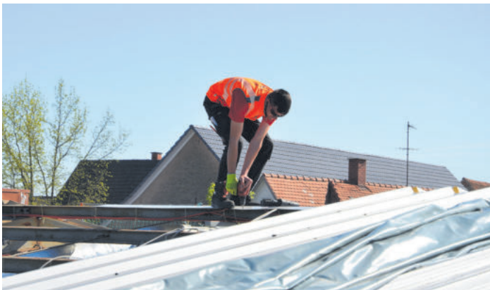
Auf dem Dach der Erwin-Maurer-Halle sollen nach der energetischen Sanierung Photovoltaik-Module installiert werden. Foto: Stadt Kehl/Mark Gregotsch
